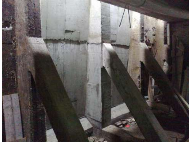
Fotografía 2. Contrafuerte del muro de atraque. Puerto Santa Fe 2016.
