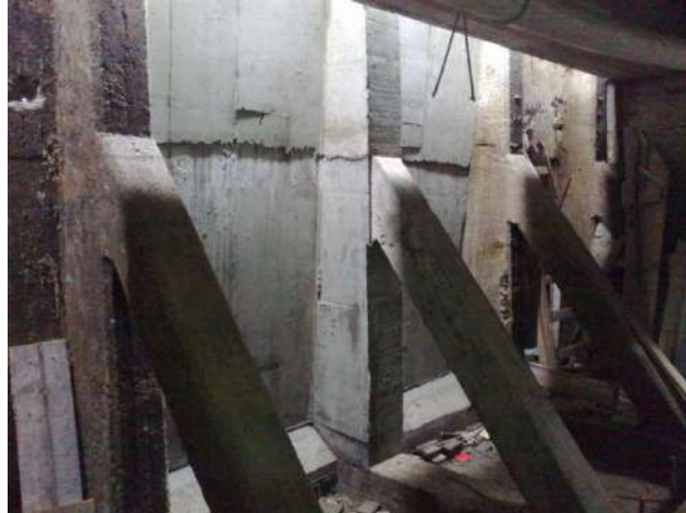
Fotografía 1. Contrafuerte del muro de atraque. Puerto Santa Fe 2016.
