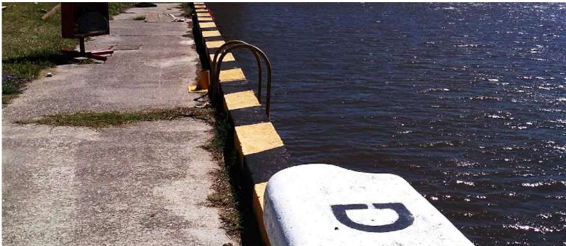
FOTO 3. Pintura en viga de coronamiento amarillo y negro con inclinación 45°.
