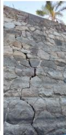
Vista Frontal del Muro
