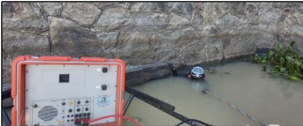
Buzo Realizando Inspección de pilotes en Punto 4
