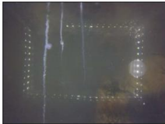
DETALLE SUBACUO DE PILOTE 2 SECCIONADO EN SU SECCION SUPERIOR
